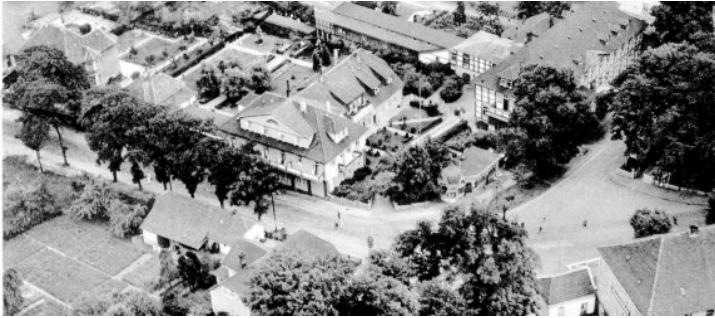
Luftaufnahme Sanatorium Lohr
